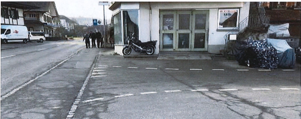
Abb. 18: Foto Einmünder Kantonsstrasse Weisses Kreuz (Quelle: RSW AG)
