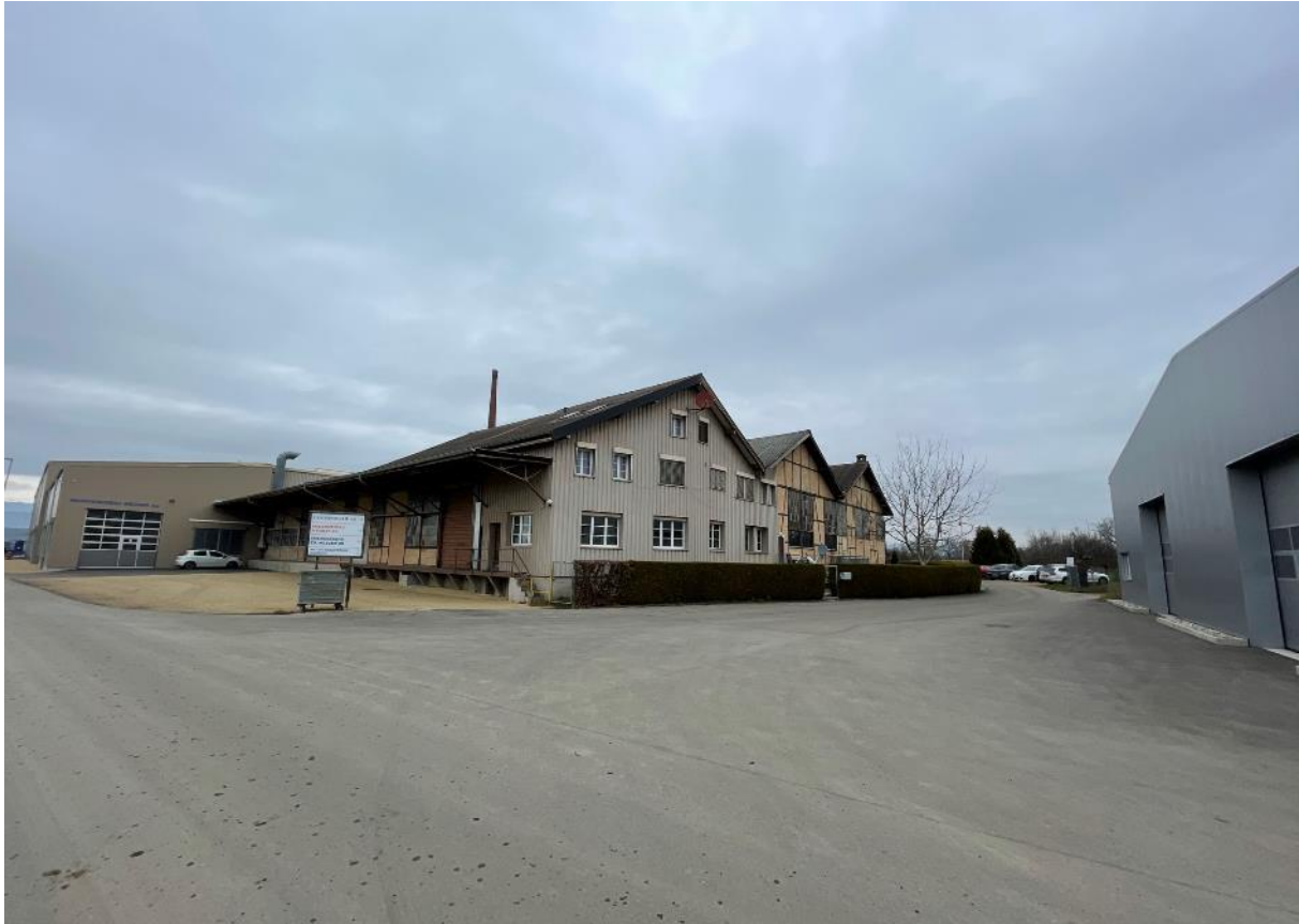
Betriebsgelände, Blickrichtung Nord
