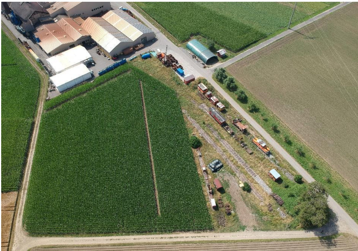
Drohnenfoto, Areal B: geplante neue Lagerhalle Camponovo AG (Parzelle Nr. 664)
