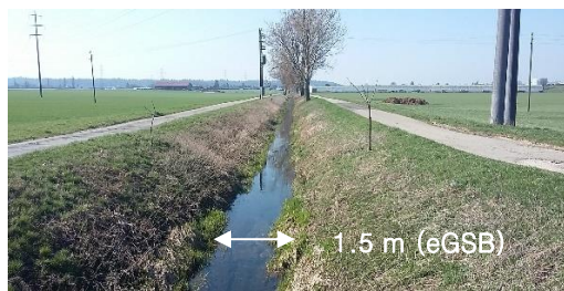
Abb. 20 Beispiel einer Berechnung der natürlichen Gerinnesohlenbreite
