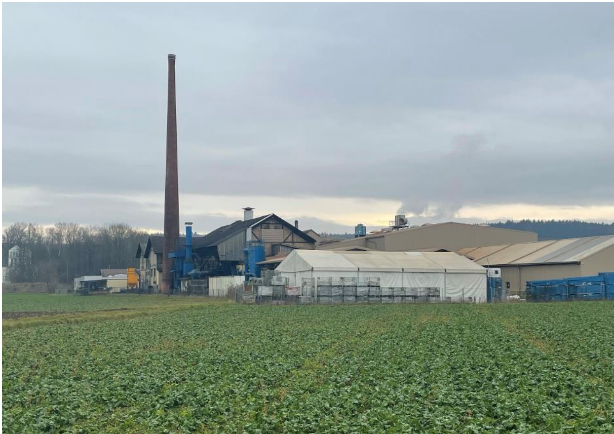
Betriebsgelände, Blickrichtung Südost; Areal A: geplante Betriebserweiterung Giesserei Ed. Mezger AG (Parzelle Nr. 178)
