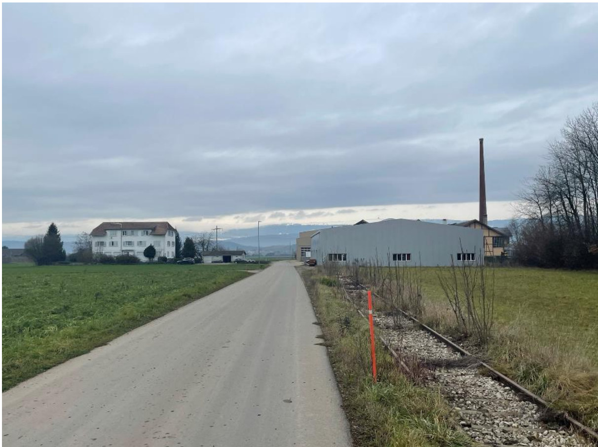
Zufahrt zum Betriebsgelände, Blickrichtung Nordwest
